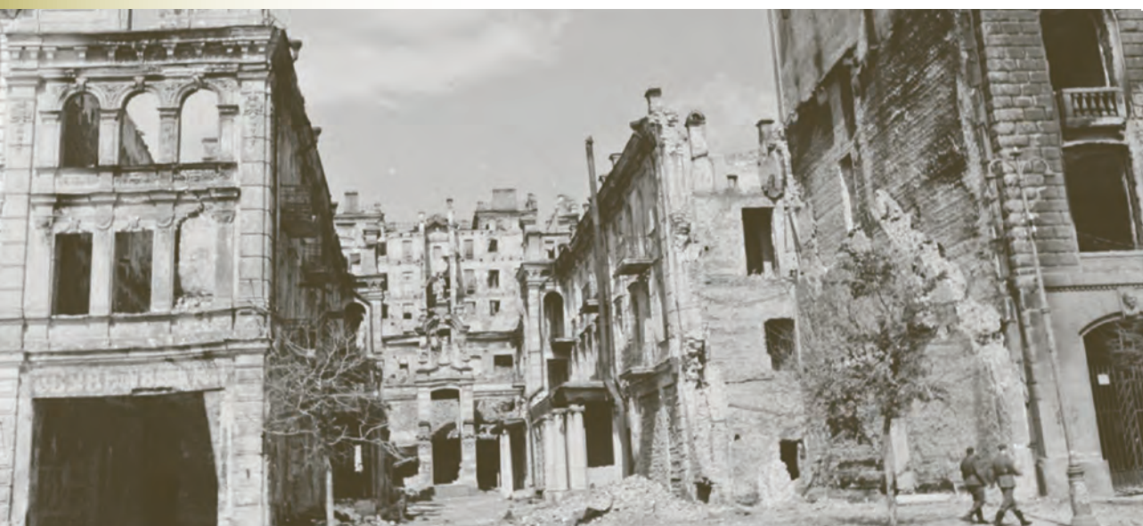
Разрушенный Малый пассаж. Справа – фасад здания Наркомфина УССР, одного из немногих сохранившихся довоенных строений Крещатина, 1942 год
